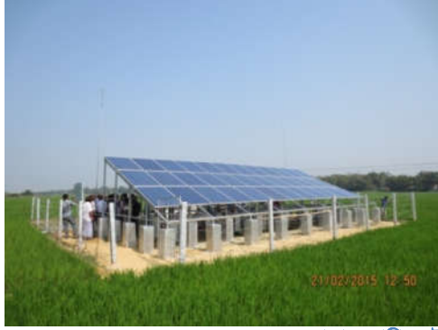
কক্সবাজারে স্থাপিত সৌর শক্তিচালিত সেচ পাম্প
